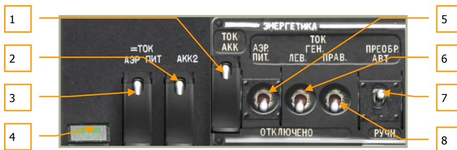
6-52: Panel für elektrische Energieversorgung
