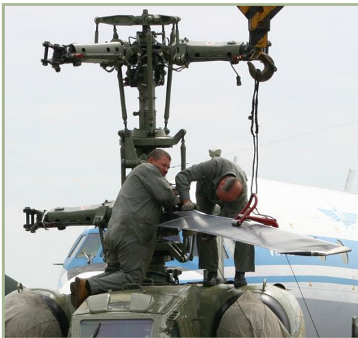
2-4: Montage des Rotors
