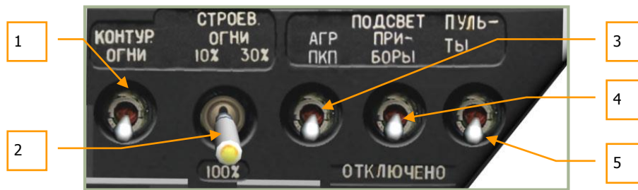
6-59: Bedienelemente für Beleuchtung
